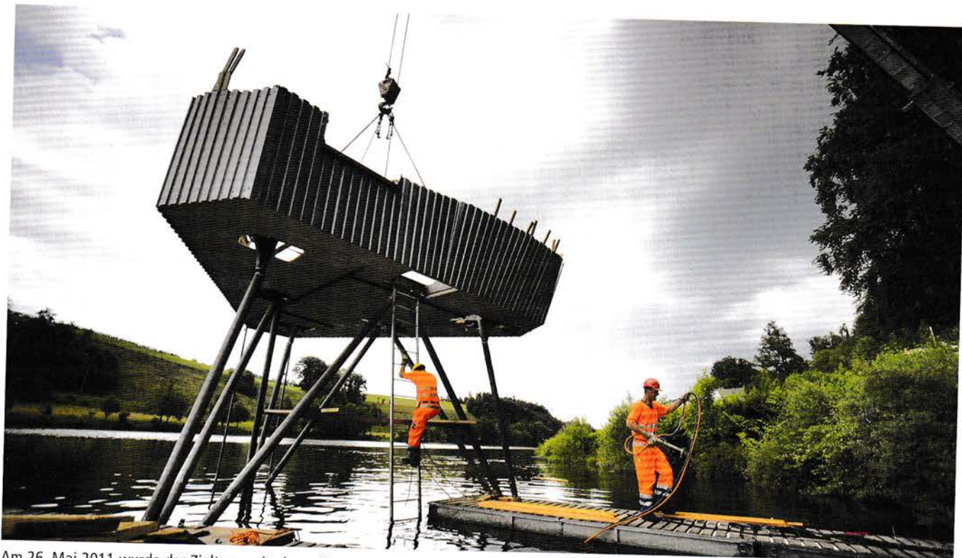
Am 26. Mai 2011 wurde der Zielturm mit einem Kran weggehievt.
